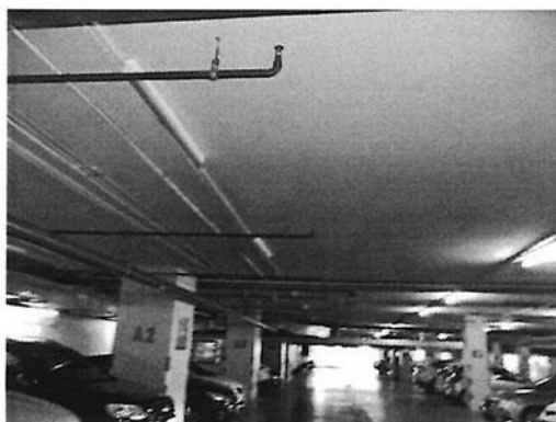
พ 3-40 ระบบดับเพลิงอัตโนมัติ (Sprinkler System)
