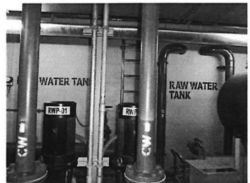
ผ 3-19 บริเวณถังเก็บน้ำดิบสำรองชั้นใต้ดินและระบบปั๊มน้ำดิบของโครงการ
